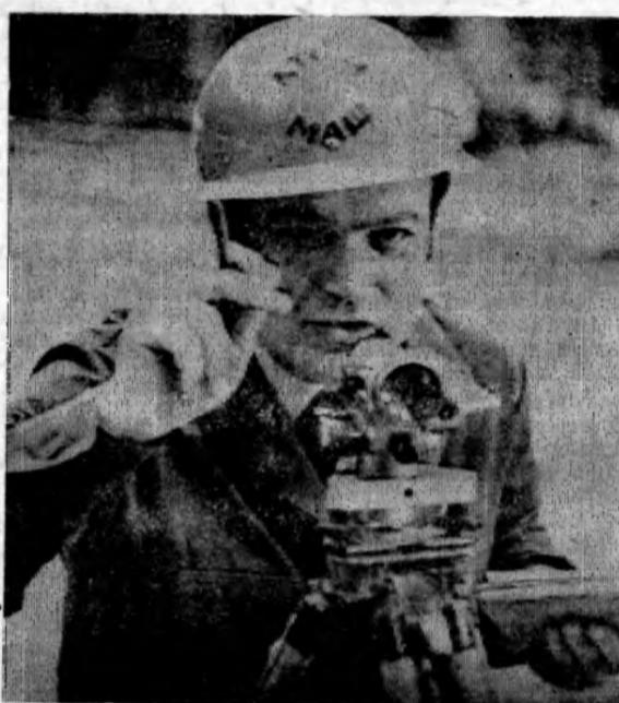
● Инженер-геодезист Н. П. Титов из СМУ-10 УС «Заводстрой» ведет разбивку отметок под полы на главном корпусе Атоммаша.
